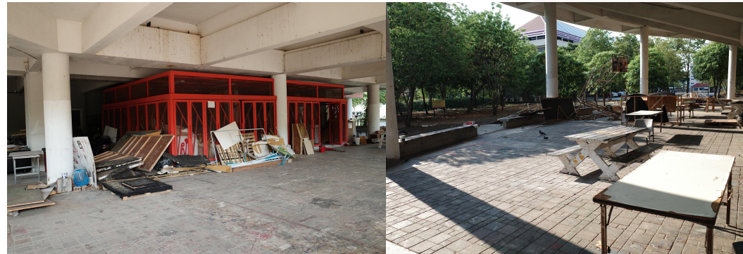
ภาพที่ 2) ภาพแสดงจากสถานที่จริงพื้นที่บริเวณใต้ Auditorium
