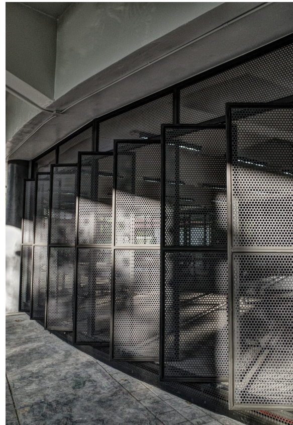
15) ภาพถ่ายแสดงทางเข้าและผนัง บริเวณใต้ Auditorium
